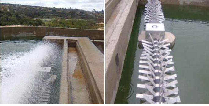
11. Brush Aerator / Fırça Aeratör
