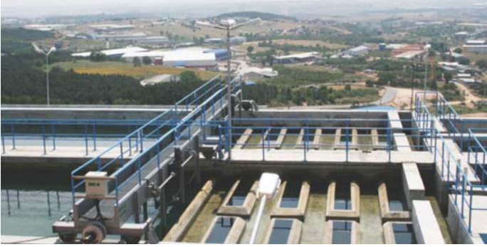
13. Scraper with Linear Bridge / Doğrusal Köprülü Sıyırıcı
