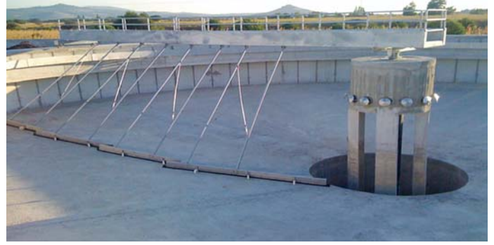
12. Scraper with Rotating Bridge / Döner Köprülü Sıyırıcı
