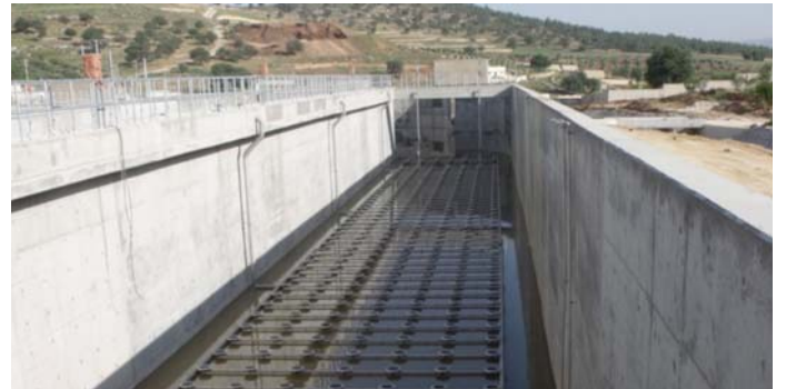
8. Difüzör / Diffuser
