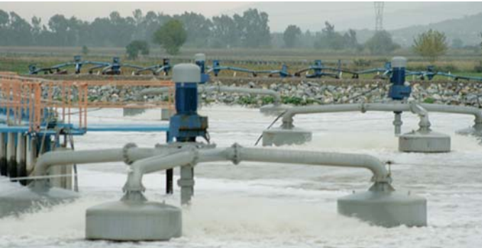
9. Surface Mechanical Aerator / Yüzeysel Mekanik Aeratör
