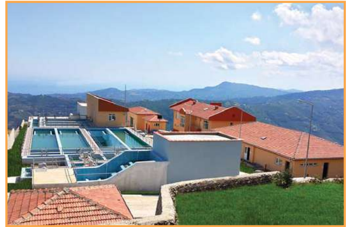
Akçaköy-Derecik-Söğütlü-Yıldızlı İçmesuyu Arıtma Tesisi / TRABZON Akçaköy-Derecik-Söğütlü-Yıldızlı Potable Water Treatment Plant / TRABZON
