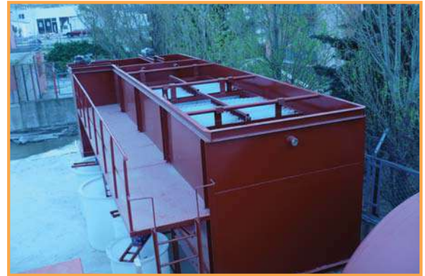
İETT Anadolu Garajı Kayışdağı / İSTANBUL İETT Anadolu Bus Terminal Kayışdağı / İSTANBUL
