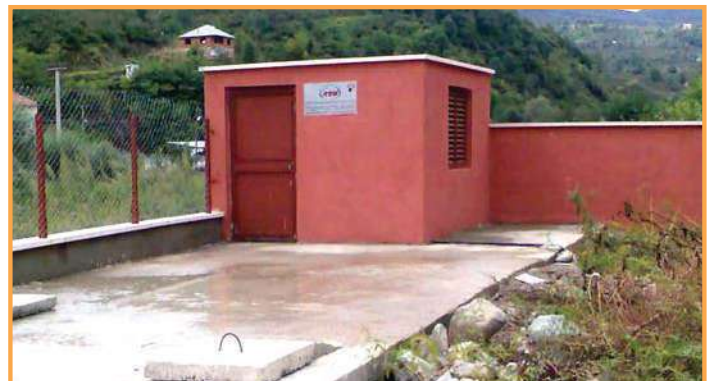
Dereli Yatılı Bölge Okulu / GİRESUN Dereli Boarding School / GİRESUN
