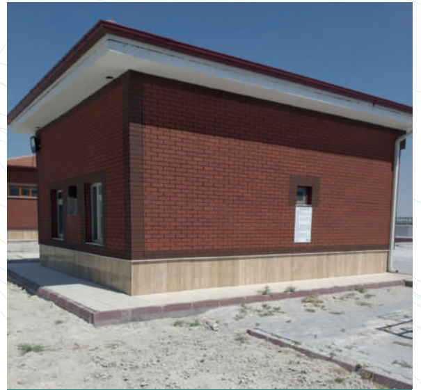
KARAPINAR (KONYA) TERFİ İSTASYONU KARAPINAR (KONYA) PUMPING STATION
