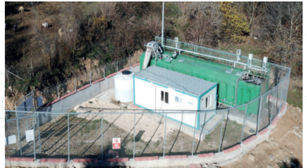
KIRAZLI (BURSA) ATIKSU ARITMA TESİSİ KIRAZLI (BURSA) WASTEWATER TREATMENT PLANT
